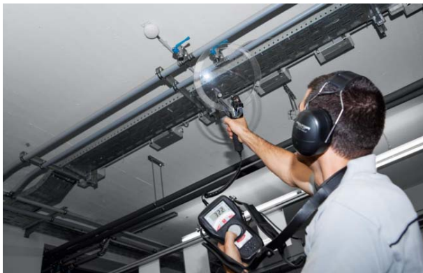
Abbildung 10: Ortung von Leckagen in der Druckluftverteilung
