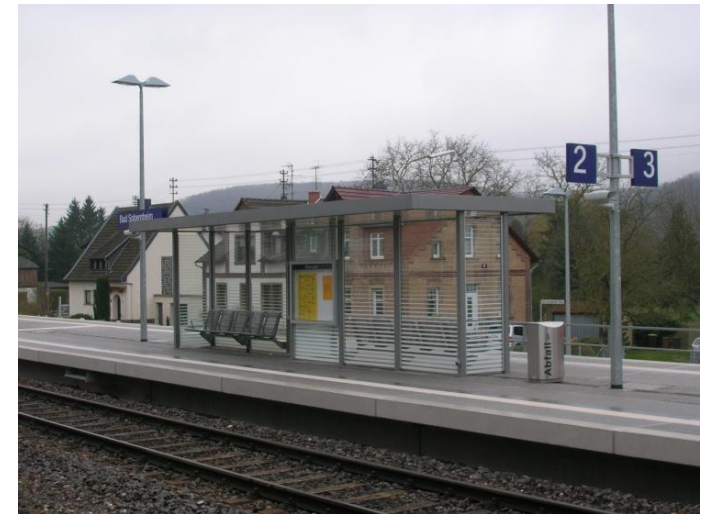
Abb.: Wartehaus auf dem Bahnsteig
